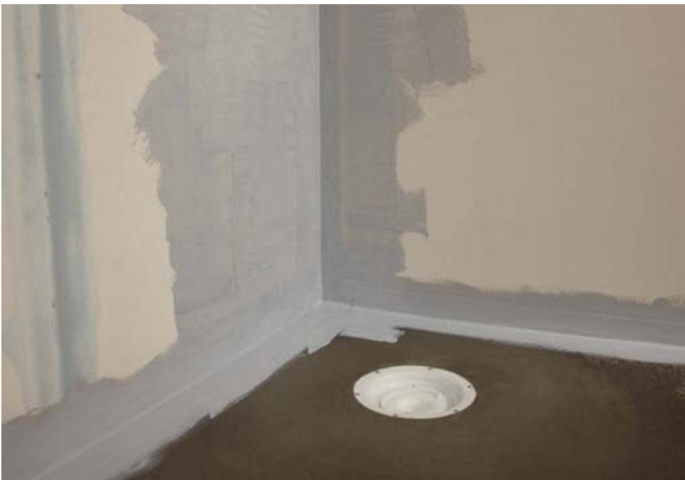
Fotografi 66. Förseglingsremsa i vinkel mellan golv och vägg.
