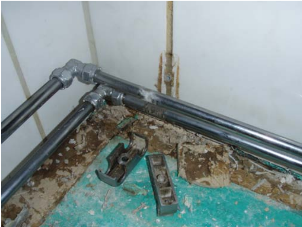
Fotografi 25. Närbild på mekanisk infästning i vägg nära golv (mätpunkt 2).
