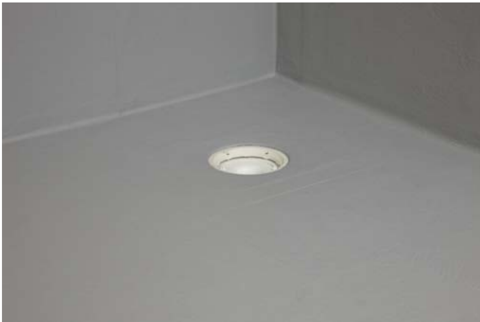
Fotografi 70. Färdigt tätskiktssystem.
