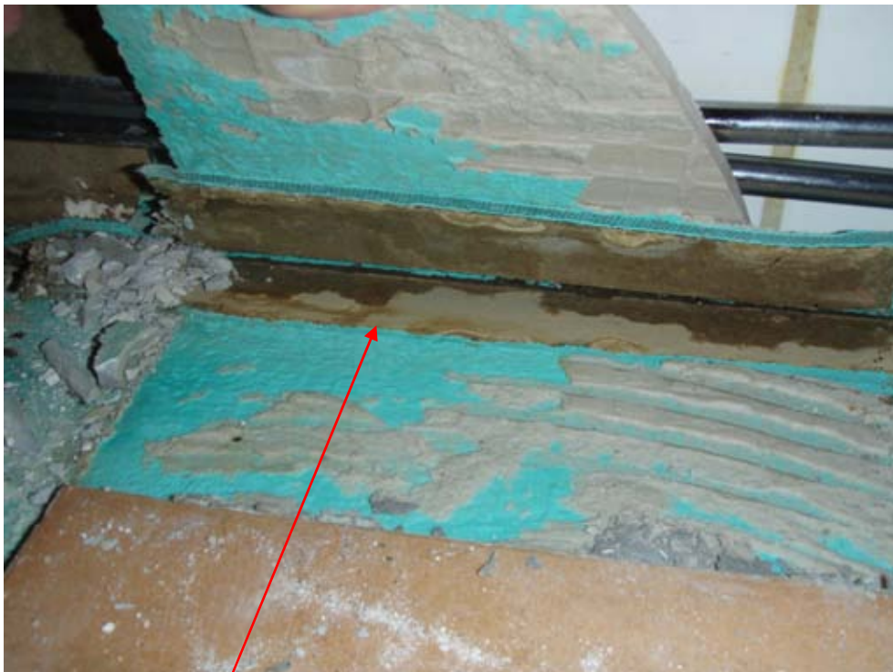
Fotografi 28. Tydlig gräns där vidhäftningen på tätskiktet upphör på grund av de olika underlagen av spackel och gips (mätpunkt 3).
