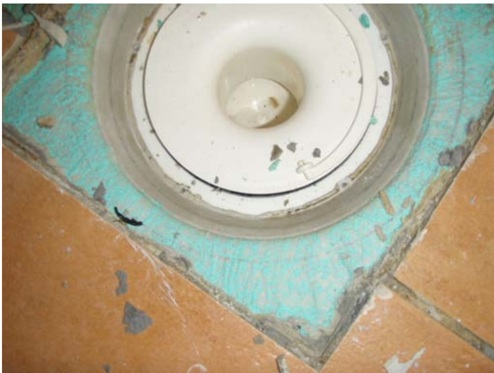
Fotografi 23. Korrekt monterad brunnsmanschett vid golvbrunn (mätpunkt 1). Observera att klämringen har skruvats bort.
