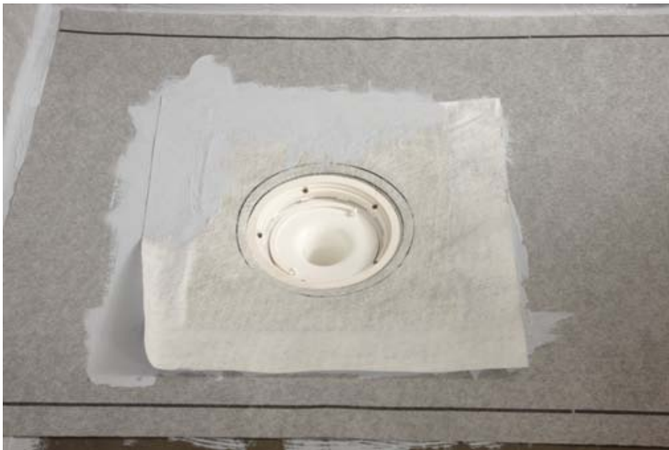
Fotografi 68. Montering av brunnsmanschett.
