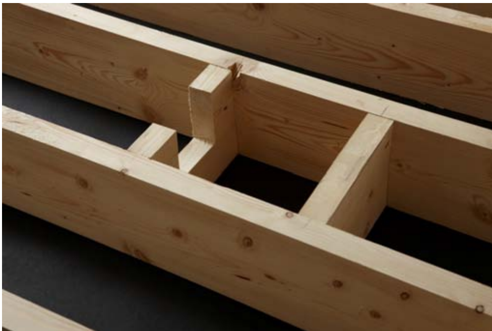
Fotografi 62. Kortlingar som stöd under golvbrunn.
