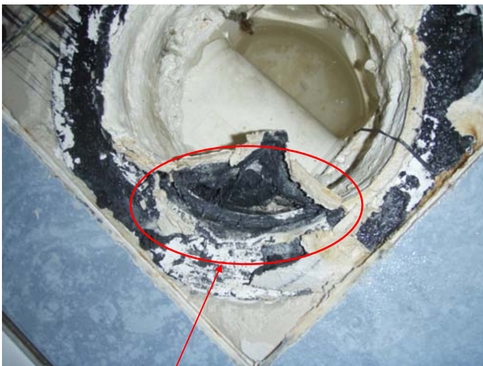
Fotografi 13. Svart brunnsmanschett/massa släpper väldigt lätt från golvbrunnen (mätpunkt 3).
