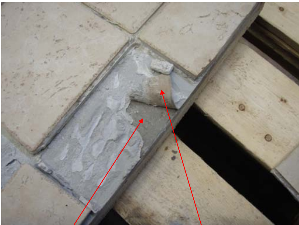
Fotografi 5. Inget synligt rosa skikt på spacklet. Svag rosa ton på baksidan av tätskiktsmassan.
