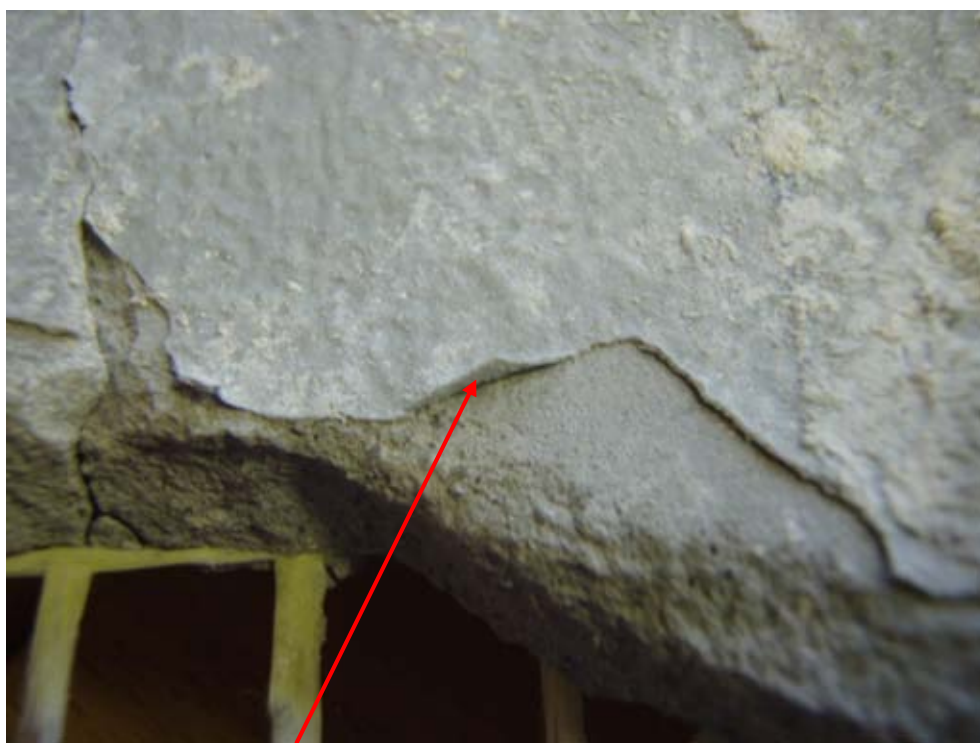
Fotografi 30. Ingen tunnflytande dispersion under den gråa gummimassan.
