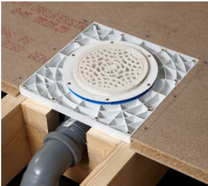
Fotografi 63. Monteringsplatta till aktuell golvbrunn samt golvspånskiva avsedd för våtrum.
