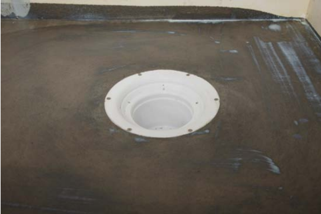
Fotografi 65. Golvbrunnens fläns i nivå med underlaget för tätskiktet.
