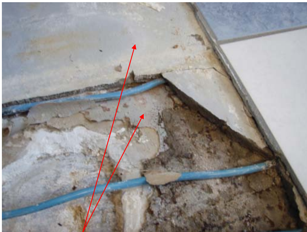
Fotografi 8. Vätskebaserat tätskikt över och under flytspackling i golvkonstruktion (mätpunkt 1).
