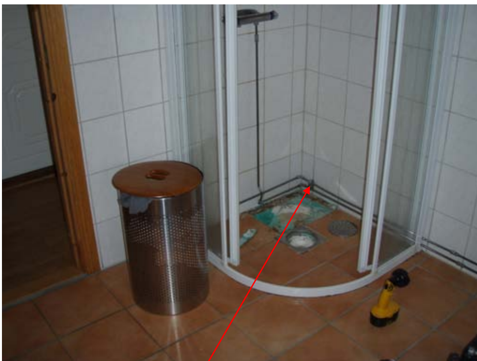
Fotografi 24. Översiktsbild över mekanisk infästning i vägg nära golv (mätpunkt 2).
