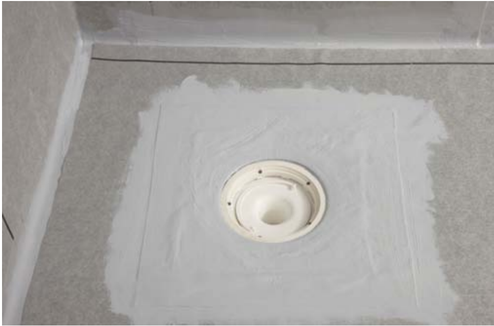
Fotografi 69. Färdig montering av brunnsmanschett och golvbrunnens klämring.
