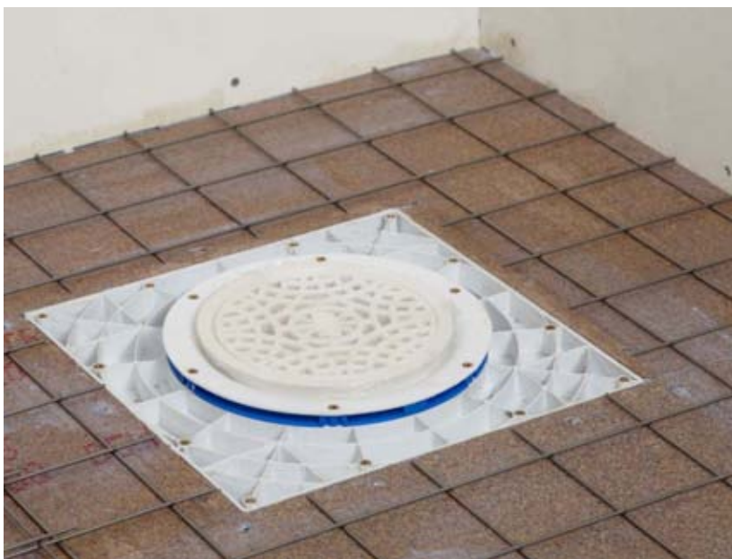
Fotografi 64. Armering av spackelskikt samt primer på golvspånskivan.
