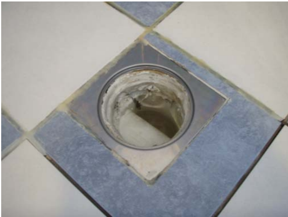
Fotografi 10. Översiktsbild över golvbrunn (mätpunkt 3).
