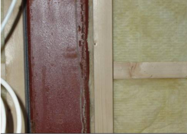
Figur 5. Tätning med isolering mot stål stolpe
