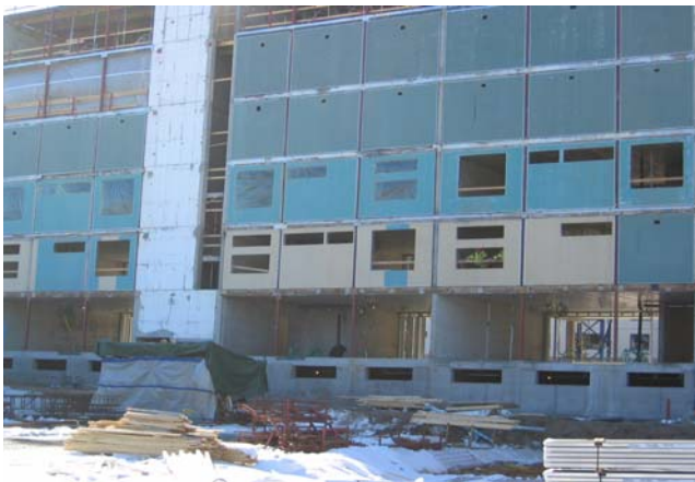
Figur 12. Utfackningselement monterade i stomme av stål och betong. Öppningar för fönster tas upp efter hand.
