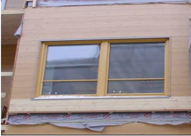
Figur 8. Prefabricerat väggelement med temporärt fastsatta kompletteringar
