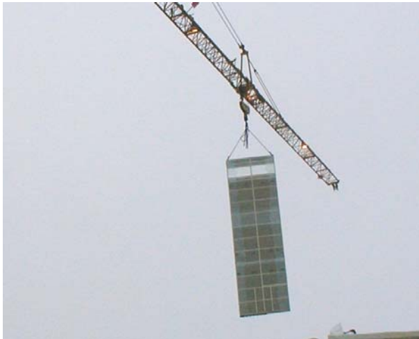
Figur 7. Lyft av planelement för montage i stommen.
