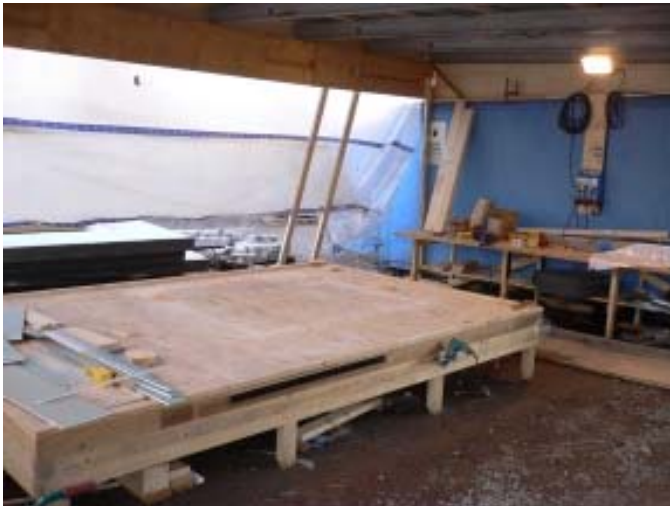
Figur 11. Utfackningselement byggs ihop i ene fältfabrik.
