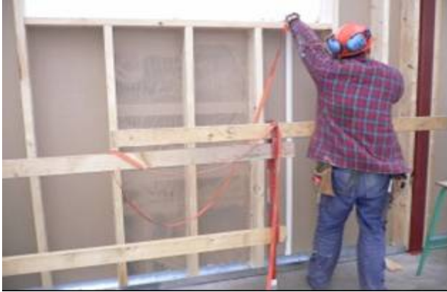
Figur 11 Montage av ett smutsigt utfacknings-element. Träreglarna hade vid montage redan synlig påväxt
