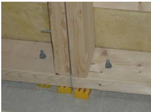
Figur 4. Infästning av utfackningsparti med bultar
