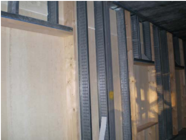
Figur 1. Utfackningsvägg med plåtreglar och träreglar som byggts på plats med utvändig skiva typ Glasroc som monterats kontinuerligt över bjälklagsgränserna och utan håltagning för fönster för att snabbt erhålla ett tåligt vädskydd.
