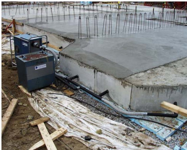
Figur 4.5 HP-systemet. Bilden visar turbinen som blåser in varm torr luft genom inblåsningsrören. Utblåsningsrören kan skymtas vid plattans mitt.
