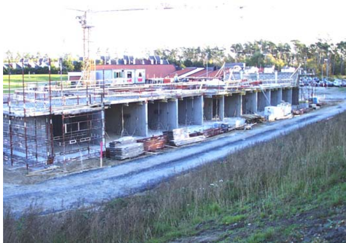
Figur 3.2 Hotelldelen under byggnation. Plattbärlaget är just monterat.
