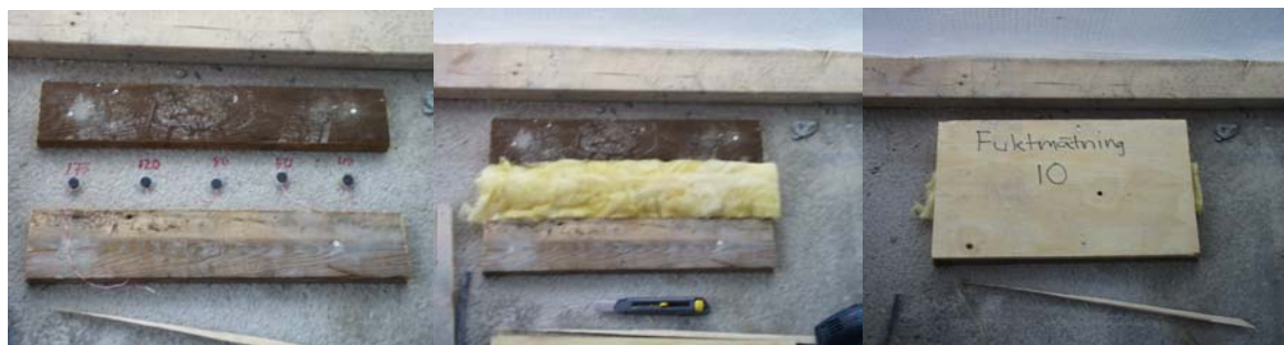
Figur 6.2 Skydd av mätpunkter under byggtiden.
