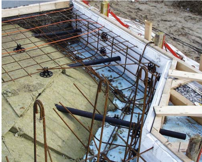
Figur 4.4 Montering av rör för HP-torkning
