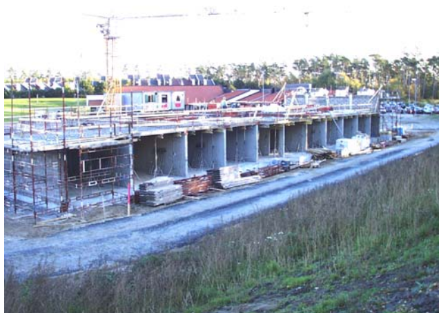
Figur 9.2 Hotelldelen under byggnation. Plattbärlaget har just monterats.
