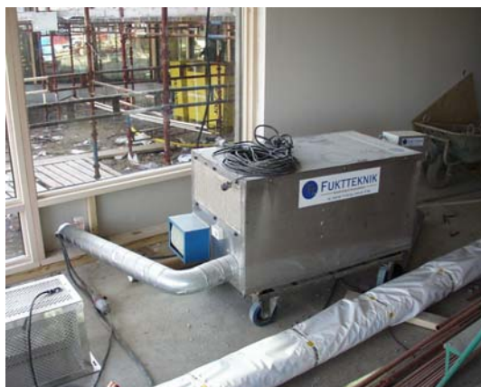
Figur 9.12 Sorptionsavfuktare.
