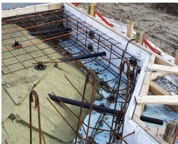
Figur 9.9 Montering av inblåsningsrör för HP-torkning.
