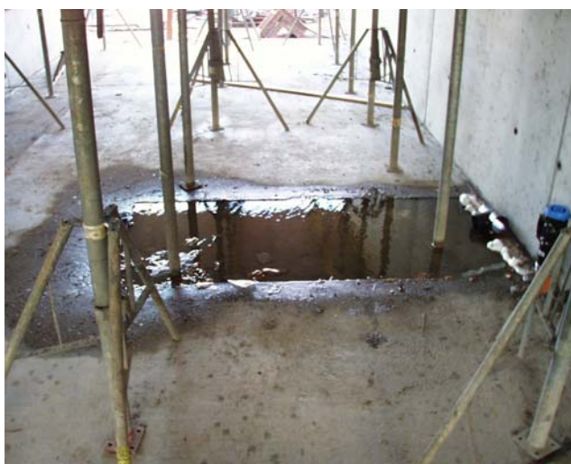
Figur 5.1 Vattenansamling i samband med nyproduktion.
