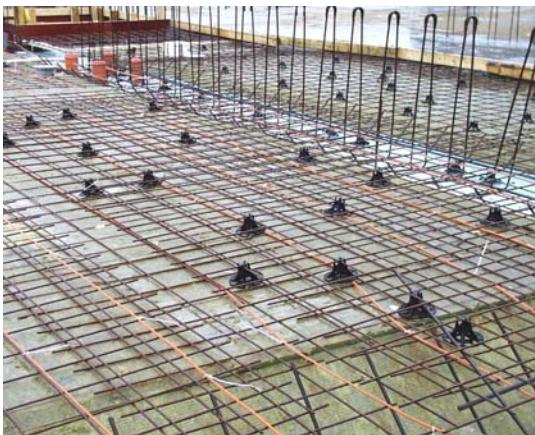
Figur 9.8 Elslingor i bottenplattan.
