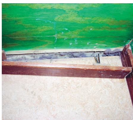
Luftintag till mekaniskt ventilerat golv som saknar dammfilter.
