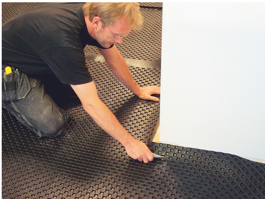
Mekaniskt ventilerat golv, Icopal System Jape, där luftspalten byggs upp med hjälp av distansmatta.
