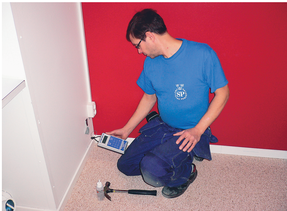
Kontroll av undertryck i mekaniskt ventilerat golv.
