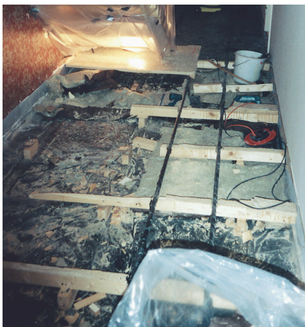
Uppbrutet uppreglat trägolv med fuktskador. Konstruktionen har ingjutna spikreglar och tjärad betongplatta.
