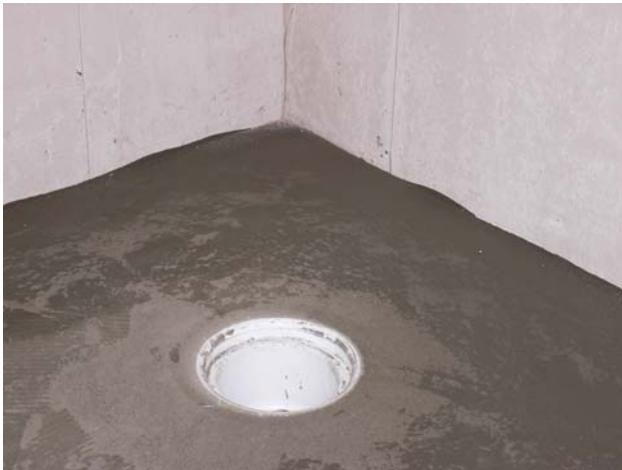
Bild 7.14 Den gamla gjutjärnsbrunnen har ersatts med en ny golvbrunn som möjliggör god tät- het mellan golvbrunn och det nya tätskiktet samt är lätt att rengöra.
