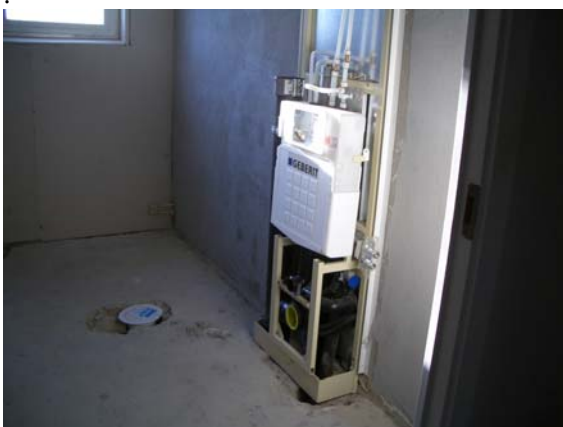
Bild 7.21 Vid installation av nya stammar kan man välja så kallade kassettlösningar som placeras i våtutrymmen. Om vatten skulle strömma ut kommer detta att ledas ut till golvet i våtutrymmet som är försett med en ny golvbrunn.
