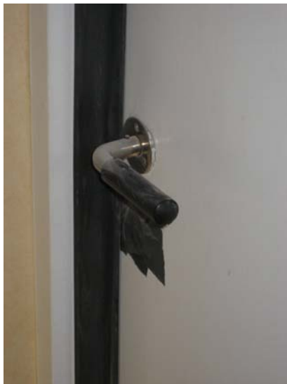
Bild 7.18 Ett enkelt sätt att hindra spridning av damm inom en lägenhet är att tätas dörröppningar. Avskärmning av arbetsområdet sker många gånger med plastfolier som ansluts lufttätt mot golv/vägg/tak.
