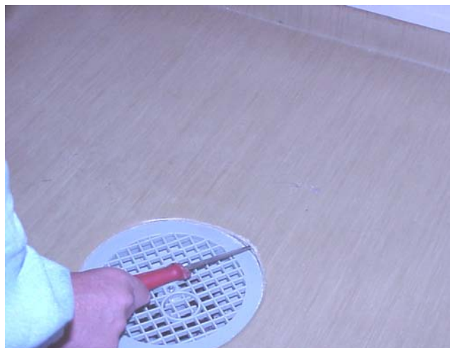
Bild 7.4 Anslutningen mellan golvbrunn och tätskikt är en viktig del att kontrollera. Mattan på bilden är inte väl ansluten mot golvbrunnen.
