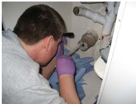
Bild 7.24 Sista delen av infodringen påförs med pensel för att undvika att materialet som påförs sprids i innemiljön.
