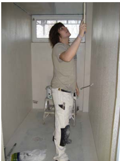
Bild 7.12 Väggen förses med en primer alternativt ångspärr innan tätskiktet rollas på.
