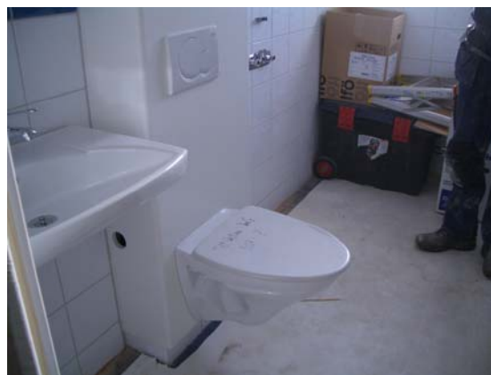
Bild 7.22 Toalettstolen monteras på kassetten som rymmer både rördragningar och vattenbehållare för toaletten.
