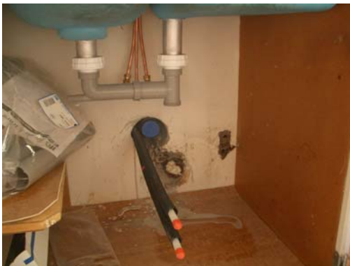
Bild 7.20 Ett korrekt monterat rör-i-rör-system innebär att eventuellt utläckandevatten kommer att föras till ett utrymme där vattenutströmningen snabbt upptäcks. Utrymmet bör även vara försett med avlopp, dvs vara placerat i våtutrymmen med golvbrunn.
