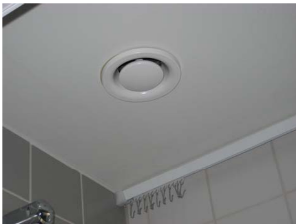
Bild 7.27 Ventilationsdon i våtrum måste rengöras för att funktionen skall bibehållas.
