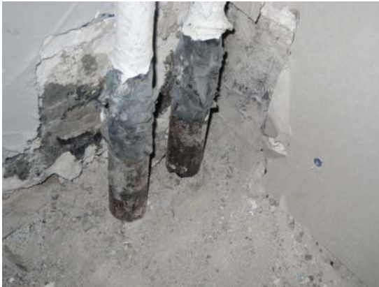
Bild 7.30 Isolering kring rör kan ibland innehålla asbest. Prover tas för analys för att kontrollera asbestförekomst.
