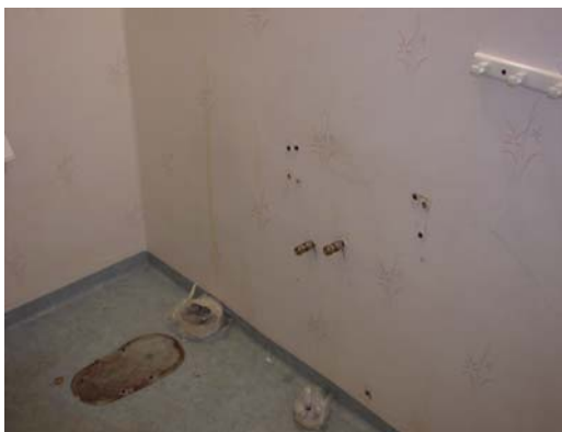
Bild 7.10 Den gamla plastmattan på väggen har många otätheter. Även otäta infästningar av toalettstol genom golvets tätskikt kan många gånger vara orsaken till fuktproblem i golv.
