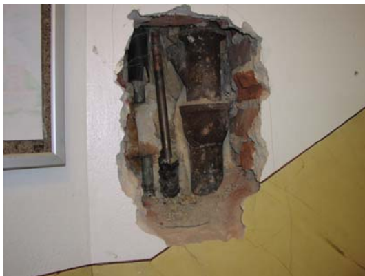
Bild 7.16 Vertikala stammar som bilats fram för att kunna inspekteras.
