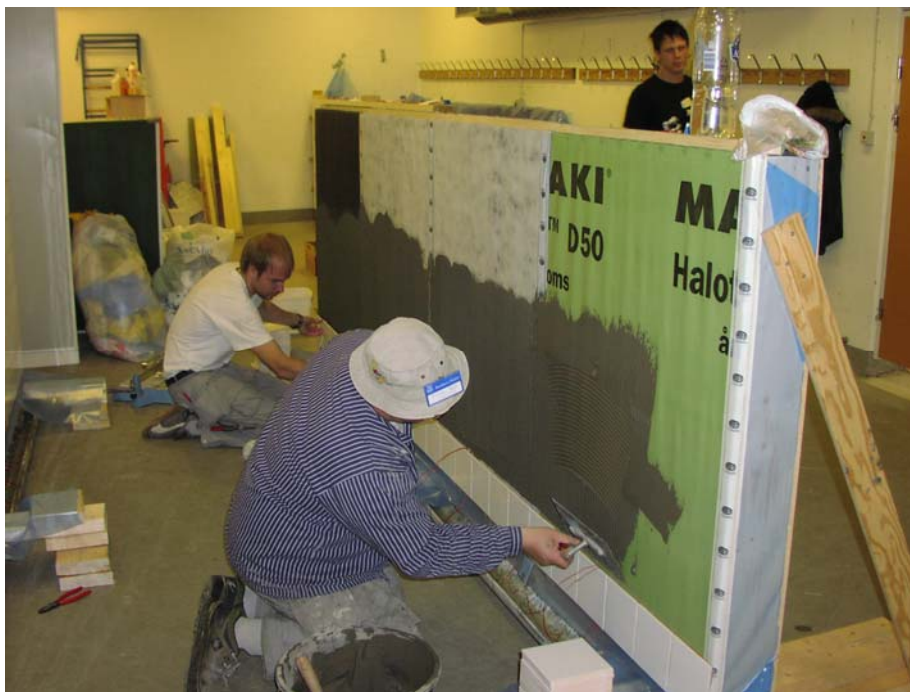
Fotografi 6. Montering av kakel och mätutrustning i fästmassa, väggsektion 3.
