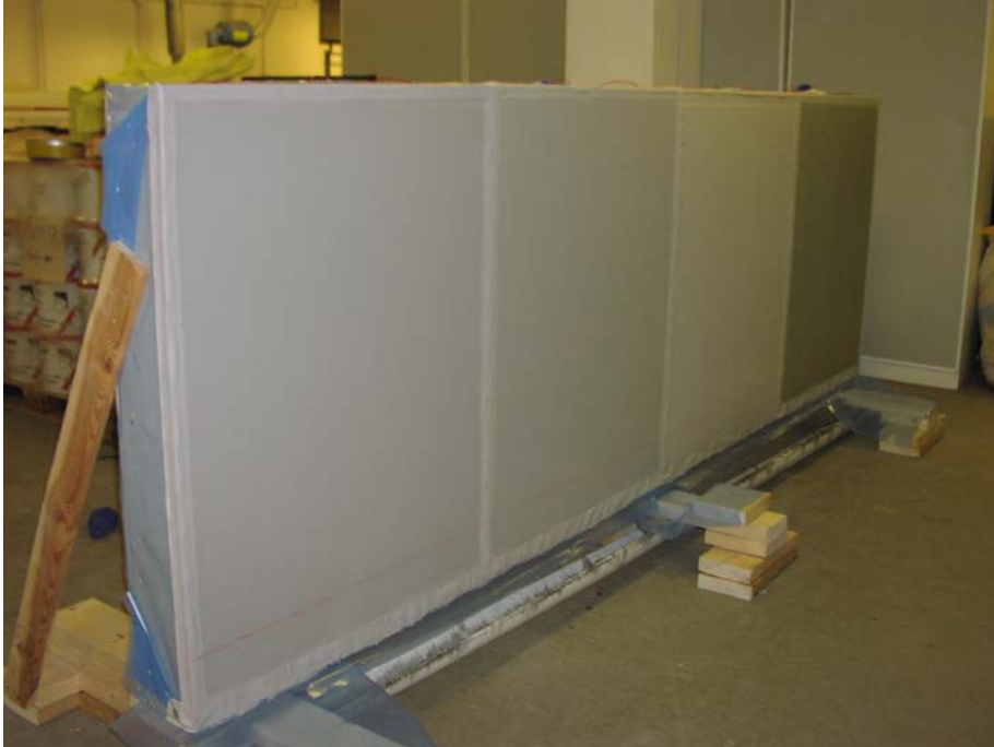
Fotografi 4. Väggelement klart för montering av kakel. Observera att det förekommer en tätskiktsremsa över skivskarvar och vägglut under tätskikten.
