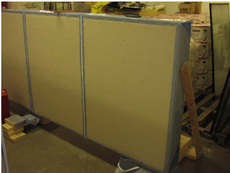
Fotografi 3. Montering av gipsskivor på väggelement. Våtrumssilikon och plastfolierem-sor hindrar fukt att transporteras i sidled mellan provväggarna.
