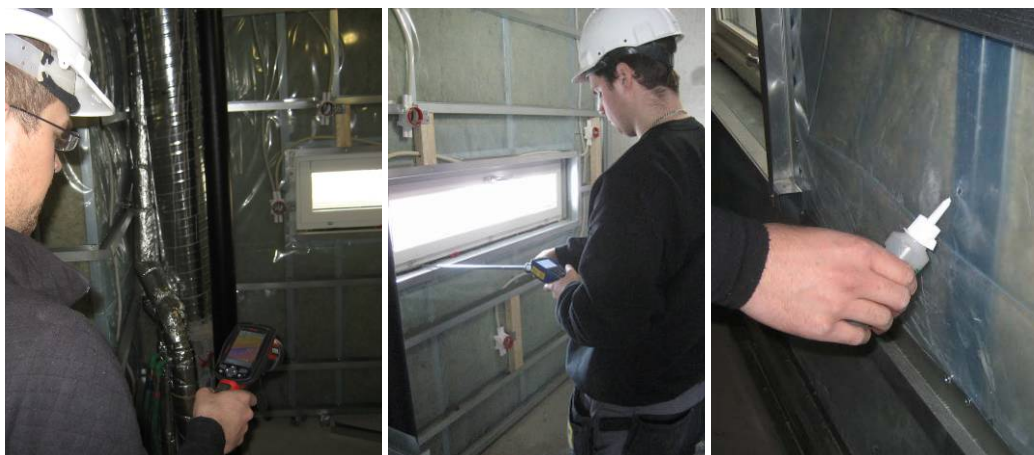
Figur 13 Läckagesökning med värmekamera, lufthastighetsmätare och rökgas.
