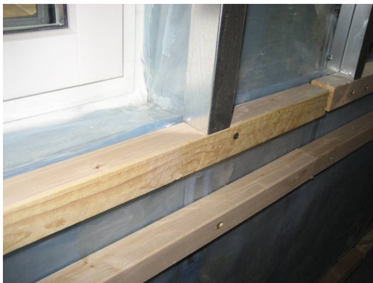
Figur 3 En tidig läckagesökning av fönsteranslutning kan utföras före den invändiga skivan är monterad. Då kan kompletterande åtgärder på ett enkelt sätt utföras.
