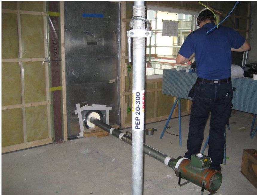
Figur 4 Täthetsprovning kan utföras före den invändiga gipsskivan är monterad.
