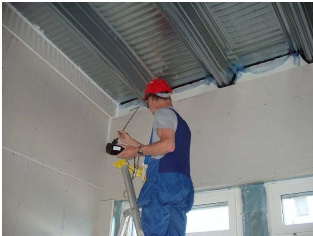
Figur 7 Läckagesökning med hjälp av lufthastighetsmätare. I fallet som bilden visar ville entreprenören utvärdera lufttätheten i anslutningen mellan yttervägg och tak. Ett rum i byggnaden sattes i undertryck och läckagesökningen kunde utföras.
