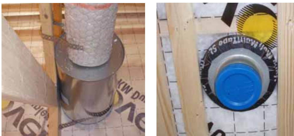
Figur 46. Kanalen avslutas med en ljuddämpare eller dylikt som innebär att kanalens isolering är helt täckt av plåt vid genomföring genom tätskikt, varvid tätskiktet kan anslutas lufttätt mot plåten.
