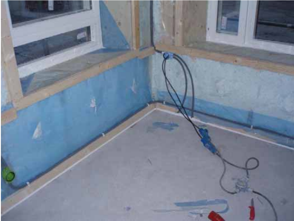
Figur 49. Hål i plastfolien för att spruta lösull.
