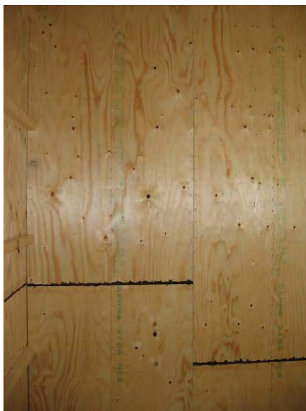
Figur 65. Bild 1 Plywood skivor på lägenhetsskiljande vägg i hörn mot yttervägg.
