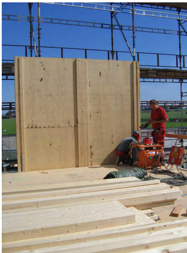
Figur 58. Montage av massiv skiva för stomstabilisering.
