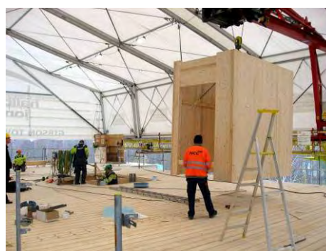
Figur 43. Montage av hisschakt.
