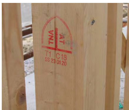
Figur 64. Regelvirke av C18, visuellt sorterat.
