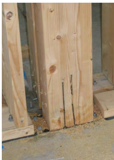
Figur 66. Insticksmontage av limträpelare i lägenhetsskiljande vägg i centrumlinjen på bjälklag över plan 0, betongbjälklag.
