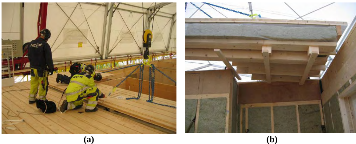
Figur 37. Montage av bjälklagselement som kan vara problematiskt att montera sett från montageplanet (a) och från våningen inunder (b).
