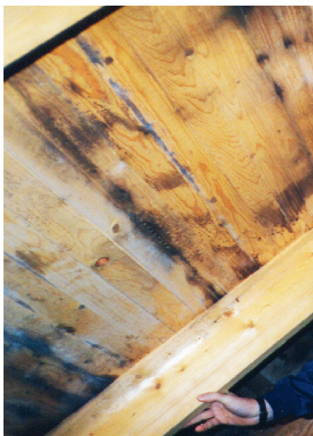
Figur 1: Mögelpåväxt på yttertak på grund av fuktkonvektion inifrån bostaden.
