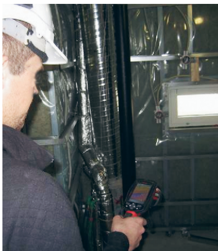
Figur 5: Läcksökning med värmekamera, luft hastighetsmätare och rökgas.
