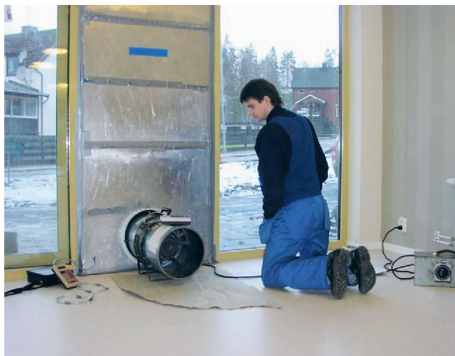
Figur 3: Mätning av lufttätthet hos en byggnad med så kallad Blower Door.
