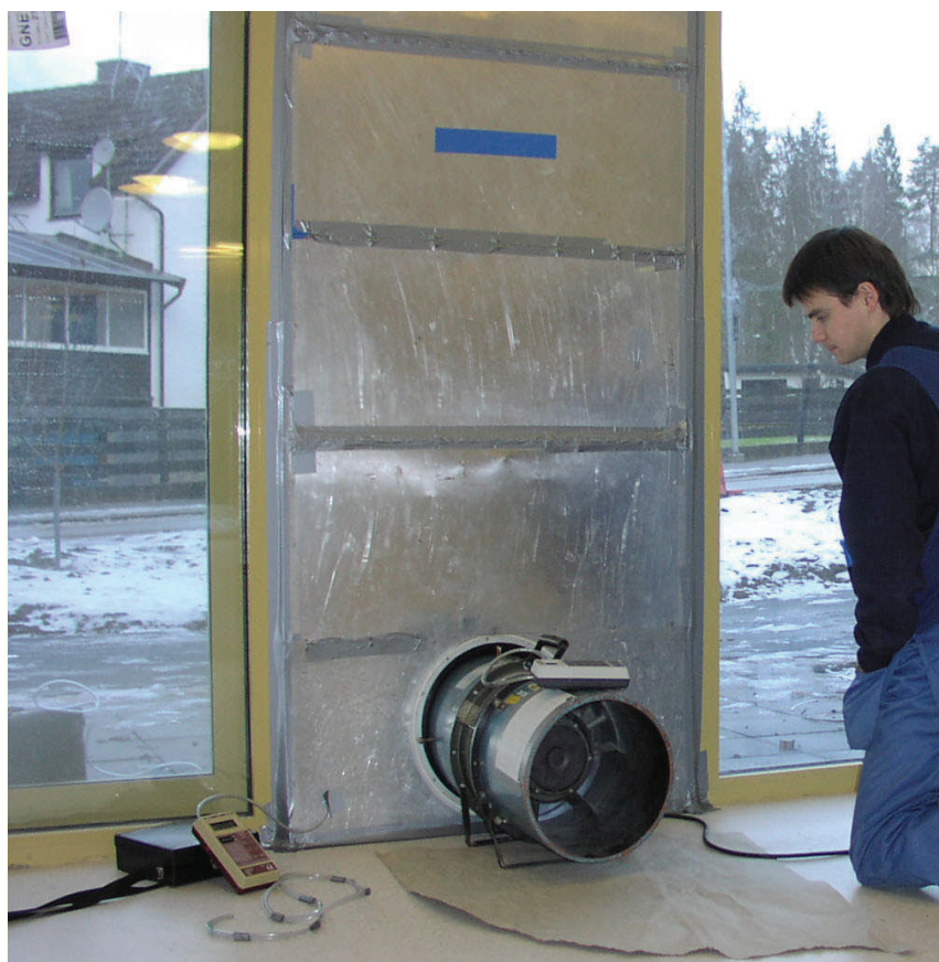
Tidig läckagesökning med en fläkt som monterats i en dörröppning. Små fläktar av denna typ används oftast vid läckagesökning i mindre byggnader eller vid läckagesökning av en begränsad del av en stor byggnad.
