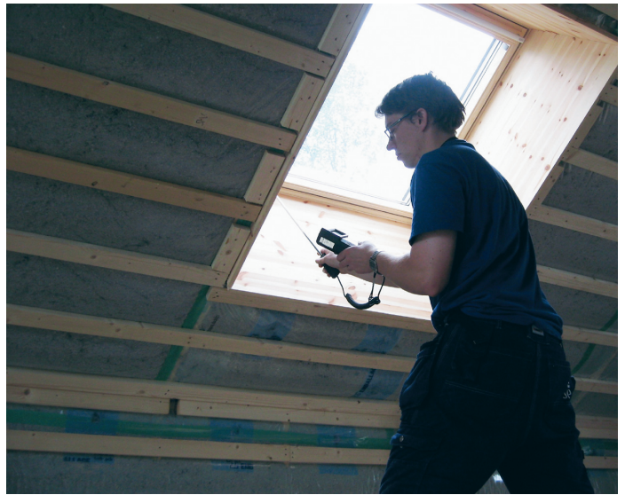
Där man har indikerat luftläckage med IR-kameran mäter man sedan upp luftflödet.
