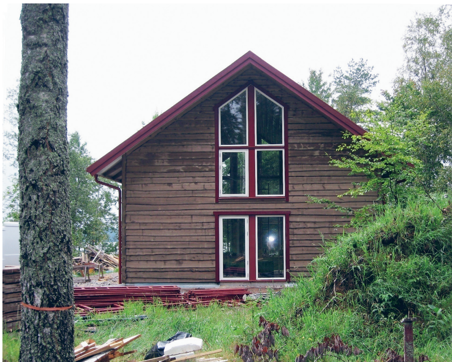
Enfamiljshus byggt som ett passivhus.
