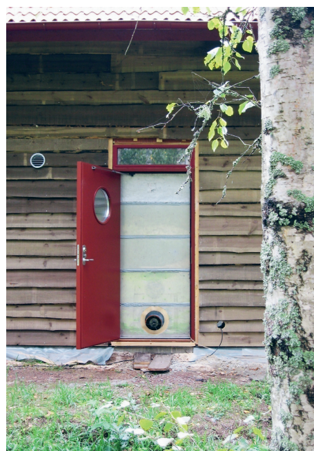
I dörren monteras en fläkt som kan blåsa in eller suga ut luft ur huset. Luftmängden som krävs för att skapa ett visst tryck är ett mått på husets täthet.
