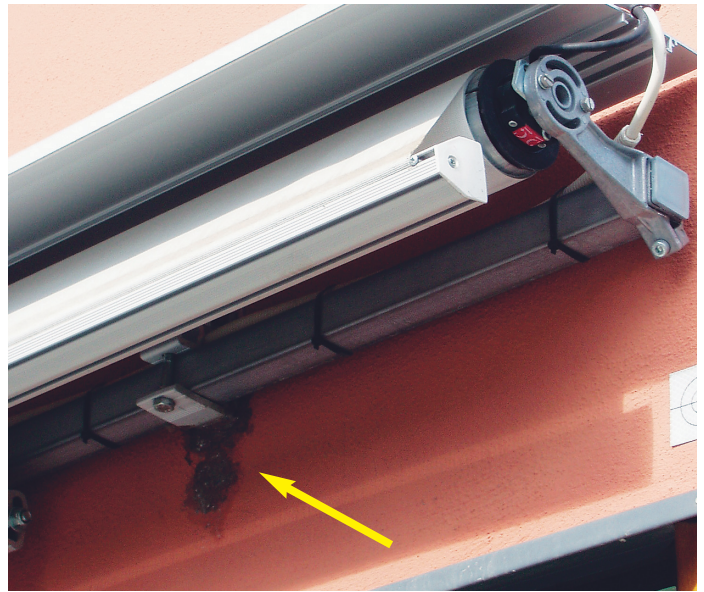
Markisinfästning med risk för läckage.
