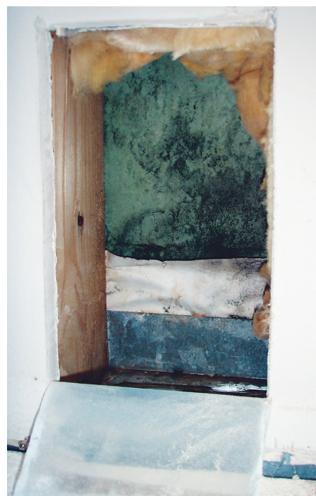
Mikrobiell påväxt på den yttre gipsskivan orsakad av att vatten trängt in vid en otät anslutning.
