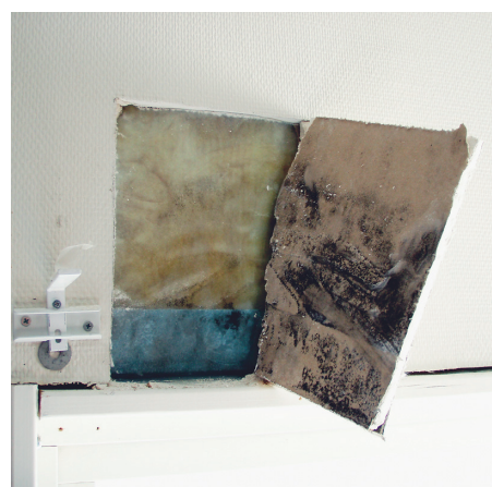
Mikrobiell påväxt på den invändiga gipsskivan orsakad av fukt som har läckt in.
