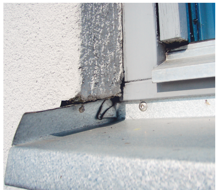
Otät anslutning vid fönsterbleck.
