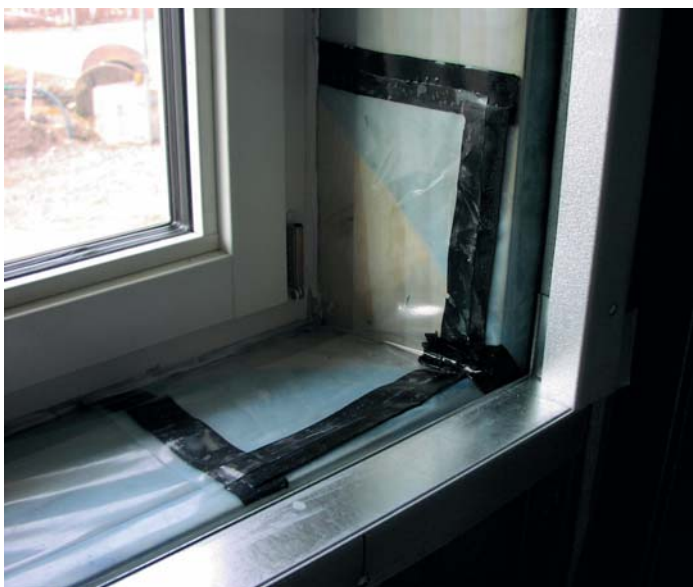
Figur 4. Plastfoliens montering i fönstersmyg samt anslutning mot fönsterkarm som visat sig ge bra lufttätthet. Bilden är tagen i kvarteret Nornan i Glumslöv.
