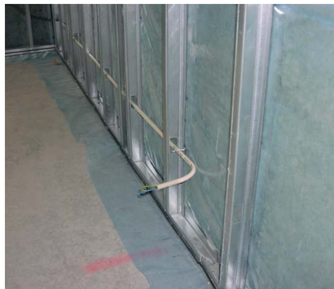
Figur 5. Plastfolien är klämd med plåttregel med mellanliggande tätremsa mot betongbjälklaget för att skapa en lufttät anslutning. Bilden är tagen i kvarteret Nornan i Glumslöv.
