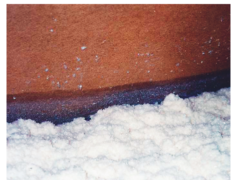
Bilden visar hur kondens har bildats på underlagstakets undersida. Om inneluften är fuktig och det inte finns något skikt i konstruktionen som hindrar fukten att vandra ut till konstruktionens kalla delar kan kondens uppstå. Det är därför viktigt att beakta hur den befintliga konstruktionen är uppbyggd innan en tilläggsisolering utförs. Tilläggsisolering av en befintlig konstruktion ökar risken för kondens eftersom vinden blir kallare än tidigare.
