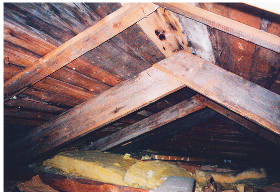
Fuktskador i tak och vindar måste alltid utredas och fuktskadan åtgärdas innan en tilläggsisolering utförs. En tilläggsisolering kan i vissa fall innebära att fuktskador förvärras.
