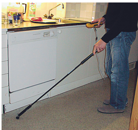
Läckande diskmaskiner kan ge upphov till fuktskador i golvet. Med hjälp av en fuktindikator som visas på bilden kan sådana skador identifieras.
