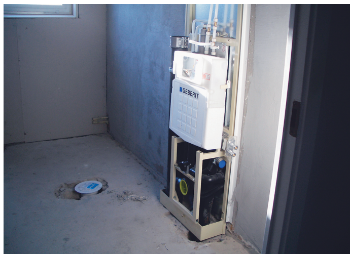
De gamla ytskikten har tagits bort för att ersättas med nytt tätskikt och ny keramisk beklädnad (bilden till vänster). Vid installation av nya stammar kan man välja så kallade kassetlösningar som placeras i våtrummen. Om vatten skulle strömma ut kommer detta att ledas ut till golvet i våtrummet som är försett med en ny golvbrunn.
