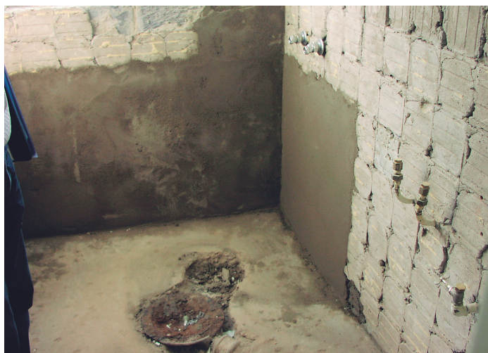
De gamla ytskikten har tagits bort för att ersättas med nytt tätskikt och ny keramisk beklädnad (bilden till vänster). Vid installation av nya stammar kan man välja så kallade kassetlösningar som placeras i våtrummen. Om vatten skulle strömma ut kommer detta att ledas ut till golvet i våtrummet som är försett med en ny golvbrunn.
