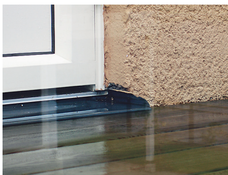
Bild 7: Otät i anslutning till altandörr.
