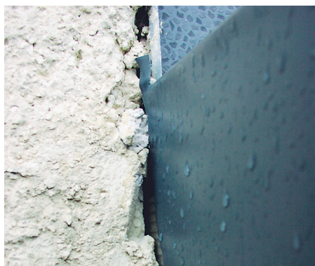
Bild 10. Otätheter vid skärmtaksinfästning.
