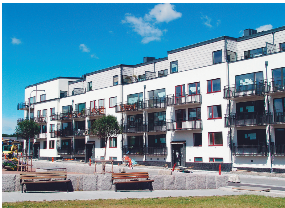
Putsade fasader är ett vanligt inslag i dagens stadsbild. För ögat ser alla husen ut att vara stenhus, men idag används putsade fasader även på hus med lätta träregelstommar. Husen på bilden har ingenting med innehållet i artikeln att göra.
