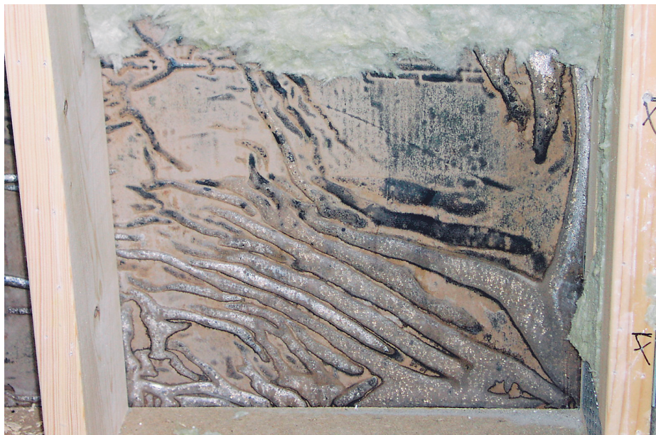
Bild 1: Fuktskadad gipsskiva mellan tätskikt och plastfolie.
