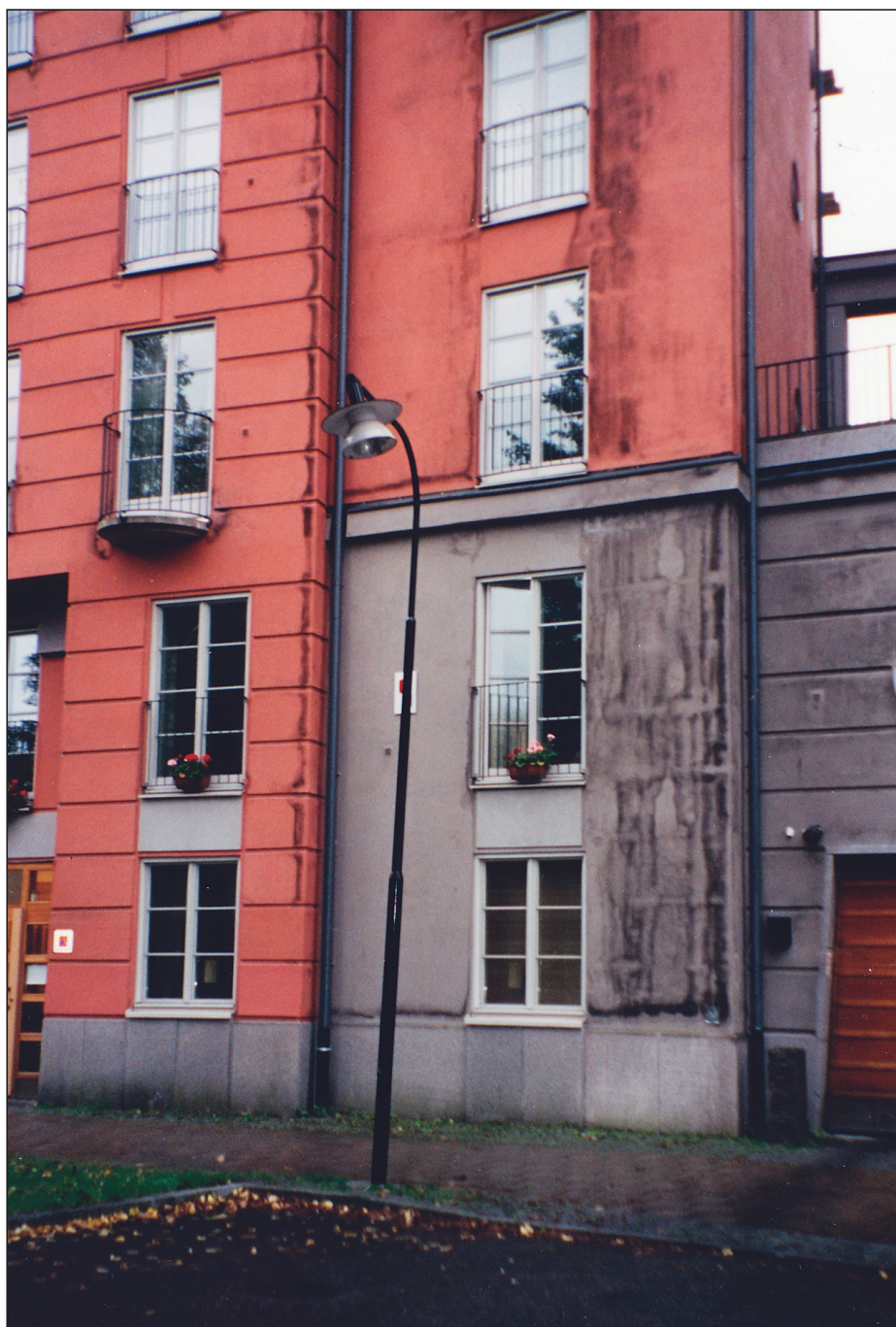
På senare tid har problemet med mikrobiell påväxt på fasader ökat kraftigt.
