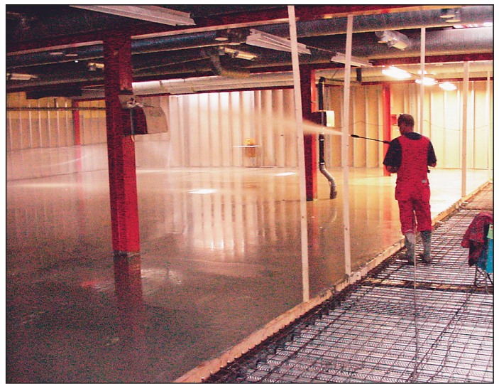
Gjutning av självkompakterande betong i fält.
