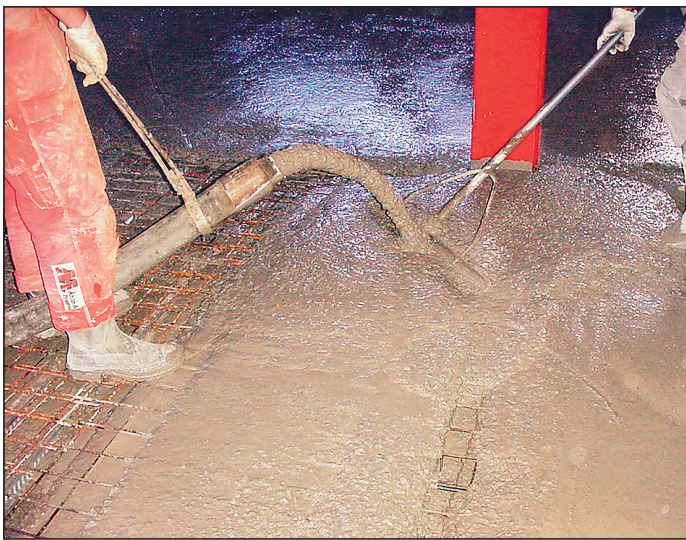
Gjutning av självkompakterande betong i fält.
