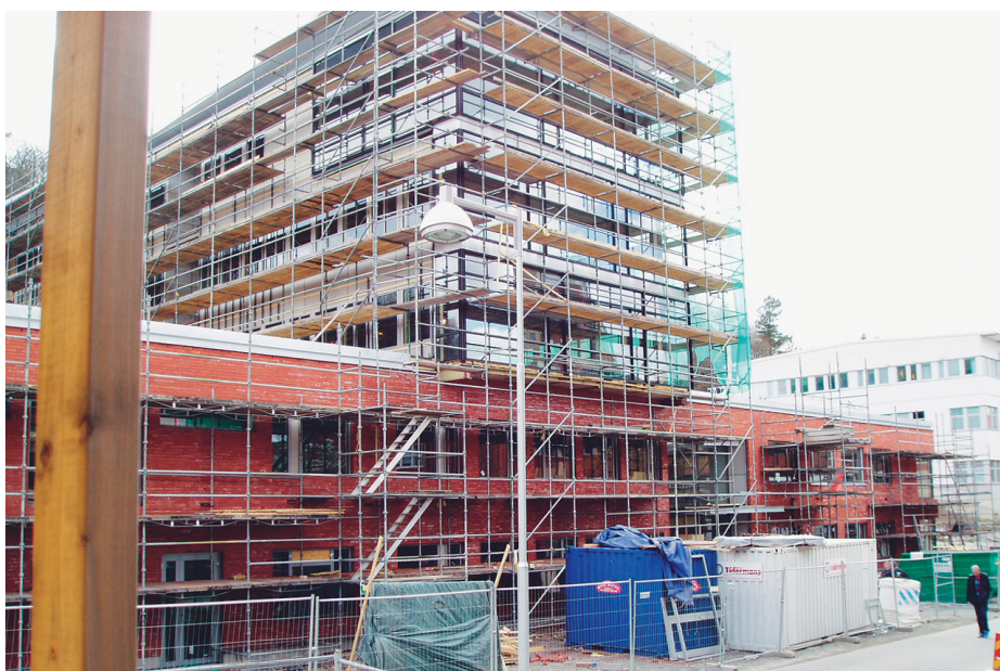
Bild 3: Vid uppförande av ny försörjningsbyggnad utförs fuktronder varannan vecka.
