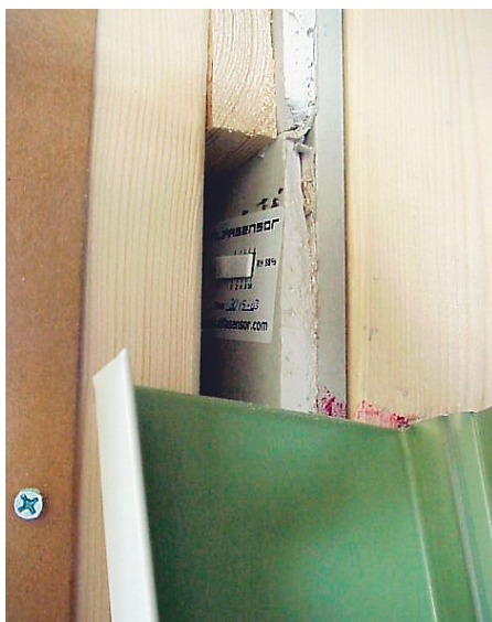
Fuktindikatorn byggs in i väggkonstruktion.
