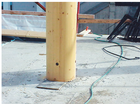
Monterad indikator i Comwoodstolpe (t Iv), samt avläsning genom inspektionshål.
