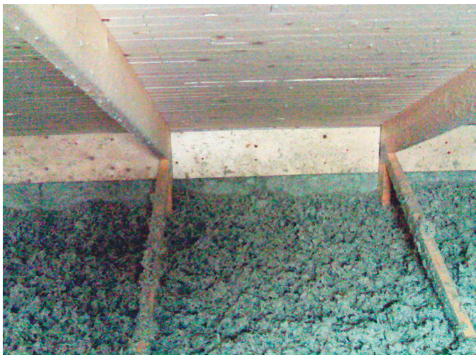
Bild 2: Ventilationen i vindsutrymmet är kraftigt reducerad genom "stängda" gavel- och takfotsöppningar.
