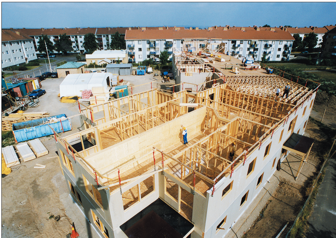
Figur 2: En byggnad med träregelstomme håller på att uppföras. Planeringen för väderskydd är av stor betydelse i de fall att man, såsom här, bygger med fuktkänsliga material som trä [3].
