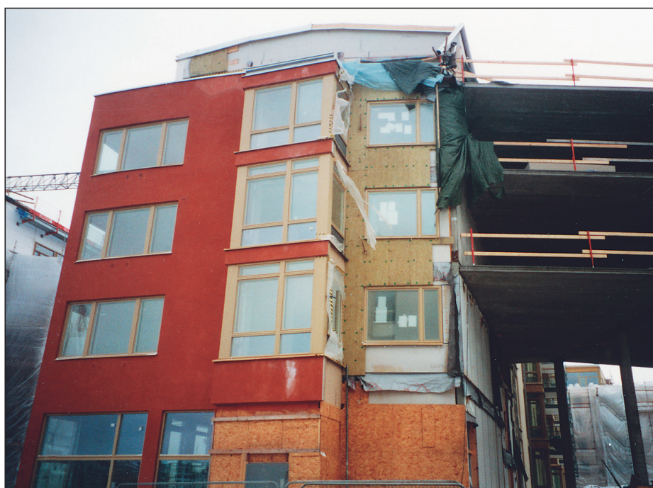
Efter hand ändrades kontrollmetoden för kv Havet till att ske utifrån. All puts togs bort liksom mineralull och utegips och därefter kunde reglarna kontrolleras.
