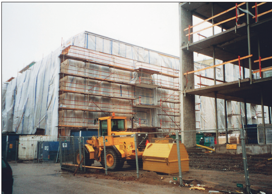
Väderskyddad arbetsplats under saneringsarbetet.
