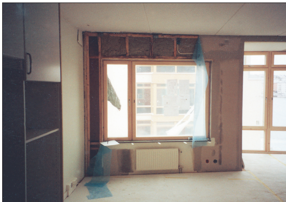
De första undersökningarna skedde genom kontroll av reglar och gipsskiva efter att invändig gipsskiva tagits bort.
