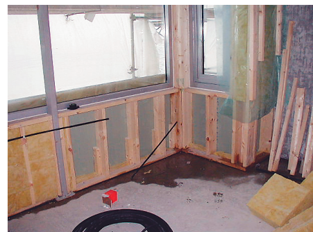
Trådlösa sensorer kan placeras i utfackningsväggar samt i betonggolv för att följa uttorkning av byggfukt och samtidigt vaka över plötsliga och oförutsedda händelser.
