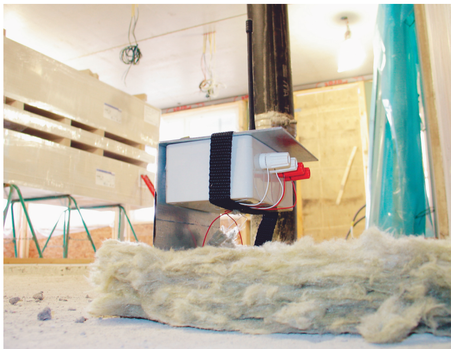
Betongdatorn är exempel på ett trådlöst mätsystem för RF i betong som utvecklats av Skanska.
